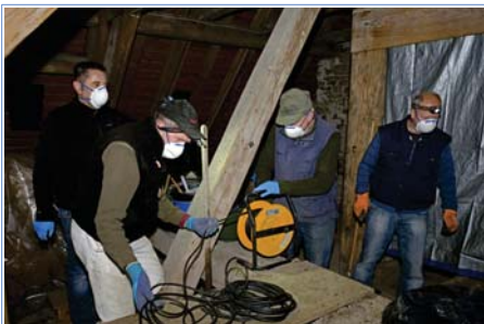
Kabelverlegung: Ohne Licht geht's nicht
