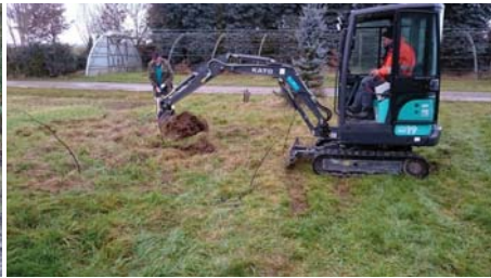
Der erste „Spatenstich“ ...
