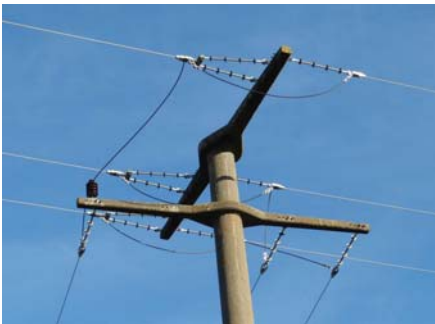
Mast - jetzt für Vögel sicher umgebaut
