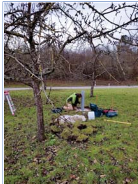
das erste Mast-Teil ist montiert
