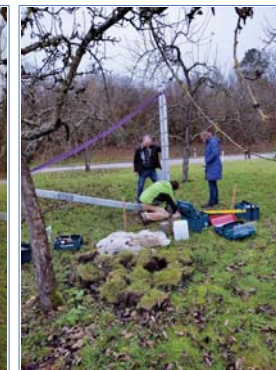
Konstruktion fürs Aufrichten
